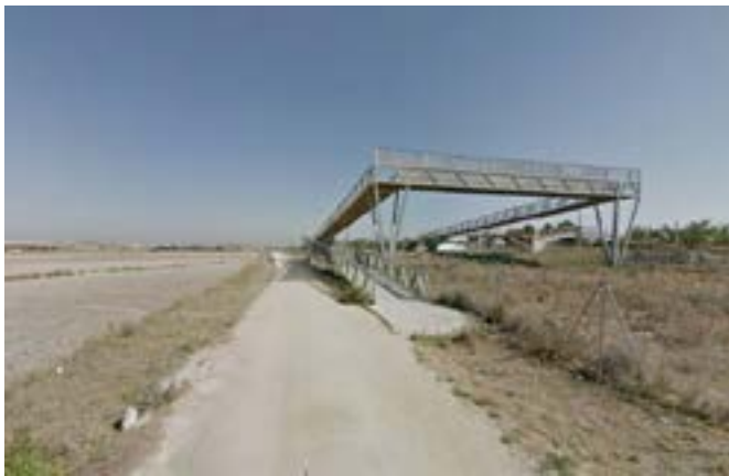
8- Vías paso Sur
