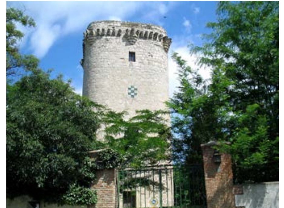
Nº 1 Torre de Éboli
