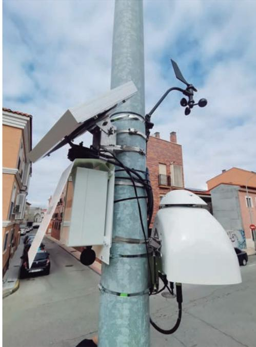
Con estas estaciones se medirán gases como monóxido de carbono (CO), monóxido de nitrógeno (NO), dióxido de nitrógeno (NO<sub>2</sub>), ozono (O<sub>3</sub>), dióxido de carbono (CO<sub>2</sub>), metano (CH<sub>4</sub>), partículas PM<sub>1</sub>, PM<sub>2.5</sub>, PM<sub>4</sub>, PM<sub>10</sub>, además de variables ambientales como viento, ruido, temperatura, humedad, presión atmosférica y punto de rocío.
