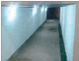
Además, con este cambio se obtiene un importante ahorro en el consumo de energía, puesto que las anteriores luminarias de halogenuro metálico consumían 3.000 w, mientras que los 20 plafones de tecnología LED instalados tendrán un consumo de
